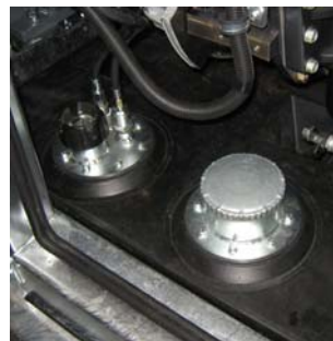
Réservoir de carburant En polyéthylène haute densité (PEHD), anti-corrosion, à double paroi d'un volume de 300 litres et situé à la base du capotage.
